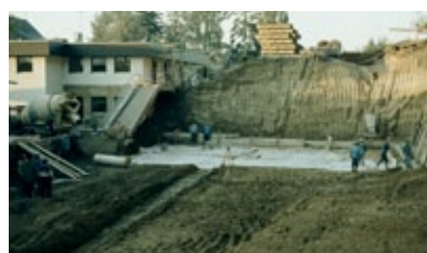
Bau des Obstverwertungs- und Lagerkellers
