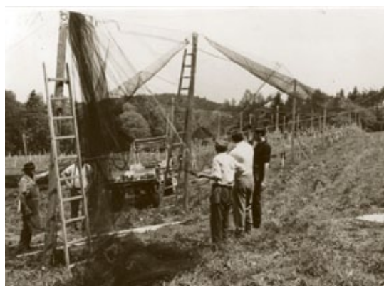
Schon Ende der 60er Jahre wurde ein Hagelnetz errichtet.
