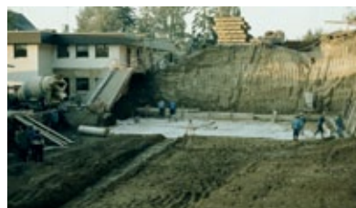
Bau des Obstverwertungs- und Lagerkellers
