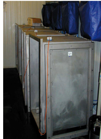
Containerlager, in denen unter CA Bedingungen die Ribisel bei etwa 2 °C gelagert werden.
