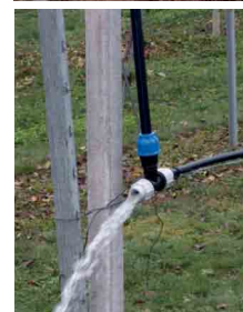
Durchspülen der Leitungen
