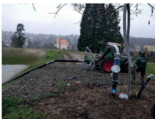
Inbetriebnahme der Pumpe
