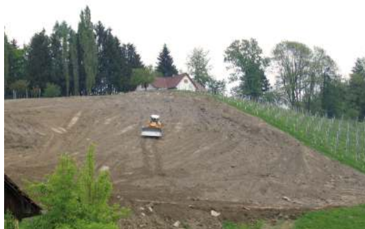
Für die Anlage des Unterlagenvergleichs waren umfangreiche Erdbewegungen notwendig.
