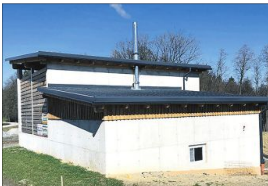
In Rekordbauzeit wurde das neue Heizwerk der Nahwärme Schamberg in der Marktgemeinde Frauental errichtet.
