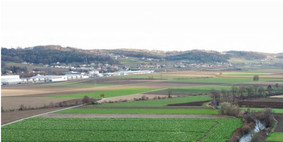
Abbildung 79: Blick zum südlichen Teil der VZ Pirching, Blickrichtung Südosten; gut ist die 380kV Steiermarkleitung erkennbar (Aufnahme: A17)
