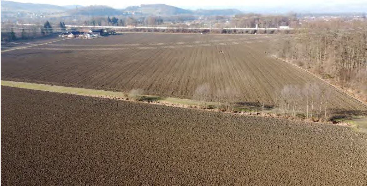
Abbildung 75: VZ Oberschwarza mit querender 380 kV-Leitung, Blickrichtung Westen (Aufnahme: A17)
