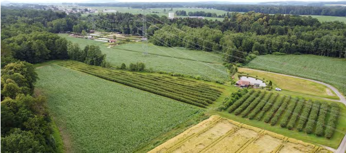
Abbildung 99: Nördlicher Teil der VZ Seibersdorf, Blickrichtung Nordwesten; 380 kV-Leitung (Aufnahme: A17)
