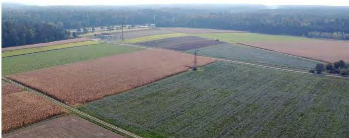
Abbildung 46: VZ Hohenbrugg, Blickrichtung Süden; 110 kV-Leitung führt zum Umspannwerk Hohenbrugg (Aufnahme: A17)
