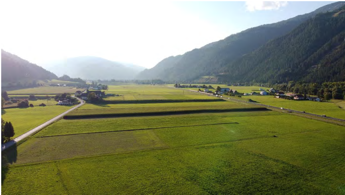
Abbildung 113: Westlicher Teil der VZ Teufenbach, Blickrichtung Westen. Die Murtalbahn und die B 69 queren den rechten Bildteil (Aufnahme: A17)
