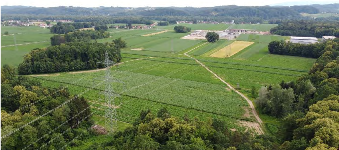
Abbildung 101: Südlicher Teil der VZ Seibersdorf; Blickrichtung Süden (Aufnahme: A17)
