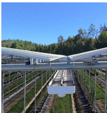
Das Dach ist vollständig regendicht. Das Wasser wird über ein Dachrinnensystem abgeleitet.
